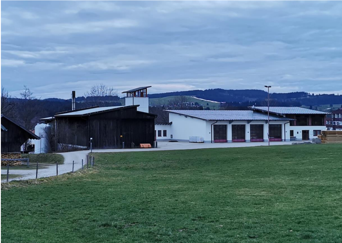
Abbildung 3-3: Blick in Richtung Westen zum Heizwerk (links) und zum Feuerwehrhaus (rechts). Im Hintergrund links ist der Schornstein zu erkennen. Foto: Sieber Consult GmbH.
